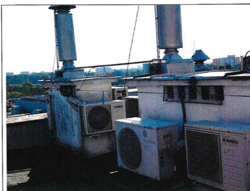
Fot. 5 Wyloty zabezpieczone kratami
