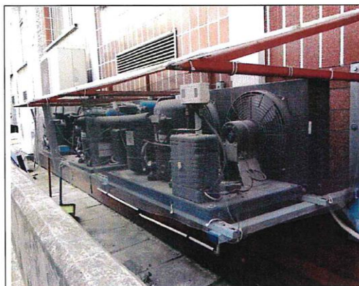
Fot. 15 Wentylatory zabezpieczone siatką – brak pierza na osłonach świadczy o raku obecności ptaków
