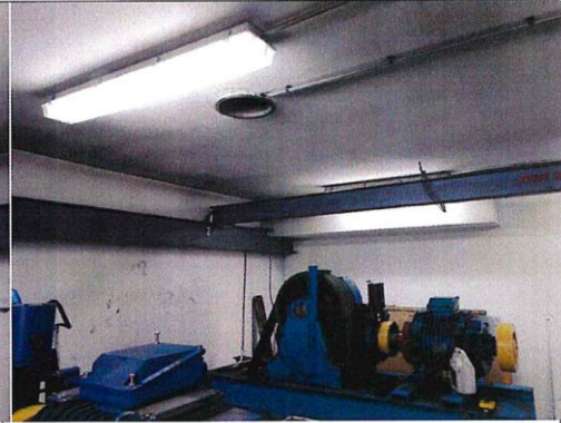
Fot. 10 Pomieszczenia dźwigowni – brak śladów obecności nietoperzy
