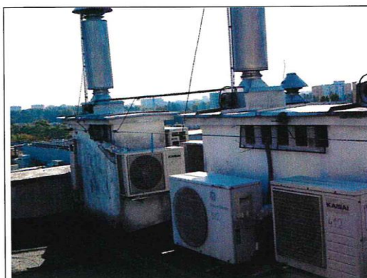
Fot. 5 Wyloty zabezpieczone kratami
